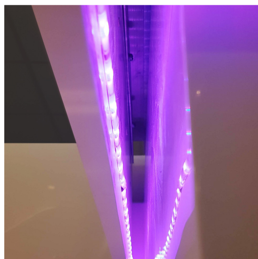
Ruban LED intégré à la retombée de finition.
